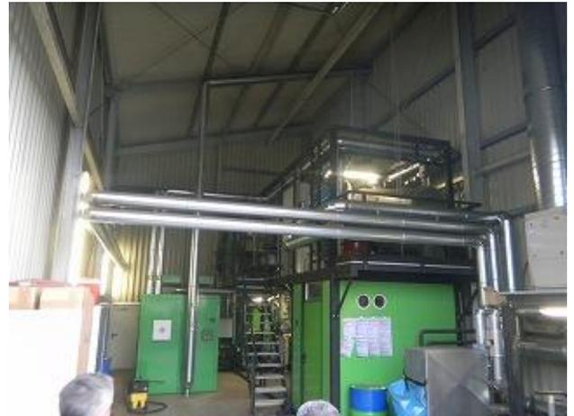
(7) この発電所は、コンスタンツ郡の公社が運営していて、ソーラーコンプレックスも出資している事業である。原材料の確保が重要で、50kW の電気と 200kW の熱を出すクラスの農家で使われている発電でも年間 1,000 m<sup>3</sup> のチップを確保しなければならない。しかも質のいいチップを調達する必要がある。全体のエネルギー需給や材の調達まで一連のシステムを考えた上で、木質バイオマス発電を導入するべきであって、設備ありきでは失敗する。
