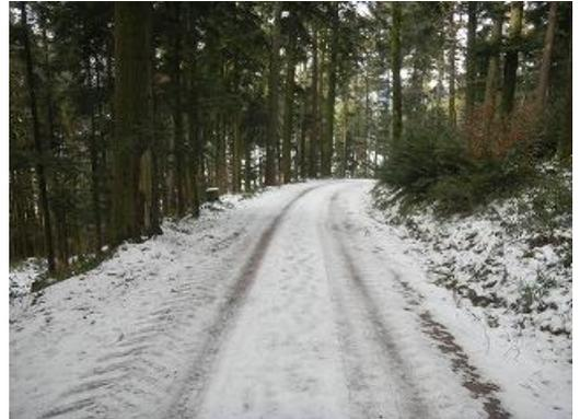
(9) 道の崩壊を防ぐには水をコントロールすることである。まず、森林基幹道を屋根型にする。10%程度の横断勾配をつけると、路面に降った雨水の半分は、直ぐに谷側の森林に分散して流される。のこり半分は、山側の側溝に集められる。この屋根型構造により、路面と路盤は絶えず乾いた状態が保たれ、崩壊のリスクが低下する。側溝に集まった水は、一定間隔で設けられた暗渠により、谷側に流す。その際、側溝に水が集まりすぎない、勢いをもちすぎないように、特に雨の多い場所では、暗渠を頻繁に設置し、水を分散
