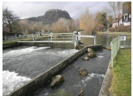
②シンゲン市でソーラーコンプレックス社が設立されたきっかけになったワークショップはこの発電所の近くで行われた。なので、設立の象徴としてもこの発電所は1日でも早く稼働させたかった。改修には約60万ユーロかかった。落差は1.8mしかない。70万kWhの電力を年間に生産する。この地域には10基の小水力発電所があるが、全て民間所有である。
