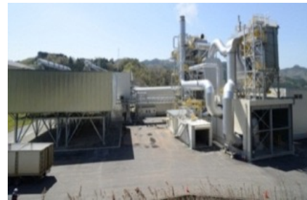
真庭バイオマス発電所 (10,000kW)
