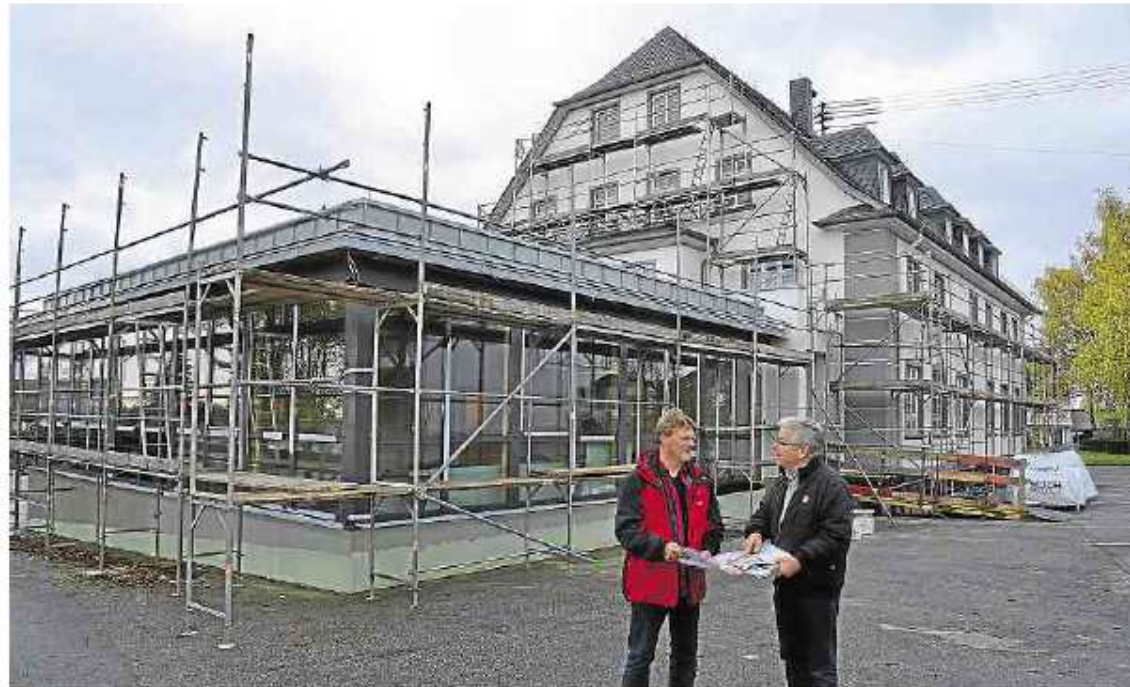
Architekt Bernd König (rechts) und Bürgermeister Toni Christ legten beim Umbau nicht nur größten Wert auf die Funktionalität des Gebäudes. Die Optik der alten Schule, als ortsbildprägendes Gebäude, wurde in die ursprüngliche Farbfassung zurück gebracht. Foto: Werner Dupuis
