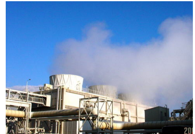
地熱発電（30000kW）
