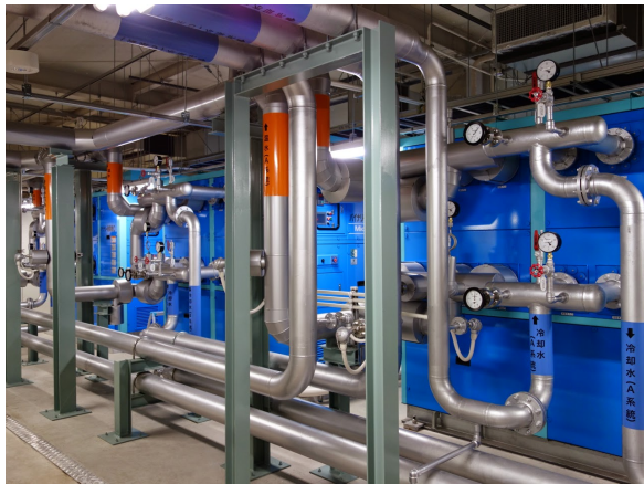
地熱発電（100kW）
