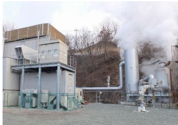
地熱発電（2000kW）
