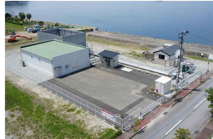
小規模地熱発電所
