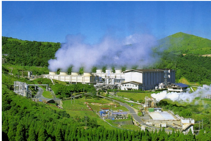
大規模地熱発電所
