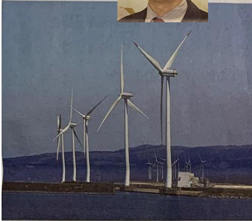
酒田北港の水路でも風力発電が行われている
