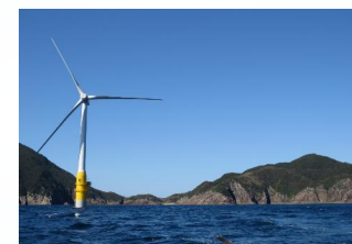
長崎県五島市柁島沖 浮体式洋上風力実証
