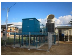
湯梨浜地熱発電所(20kW)
