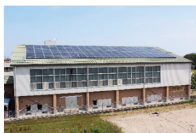
中海テレビ放送太陽光発電所(243kW)
