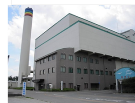
米子市クリーンセンター(4,000kW)
