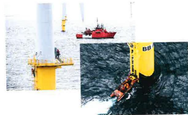
洋上風車メンテナンス風景 (ベルギー：Belwind)
