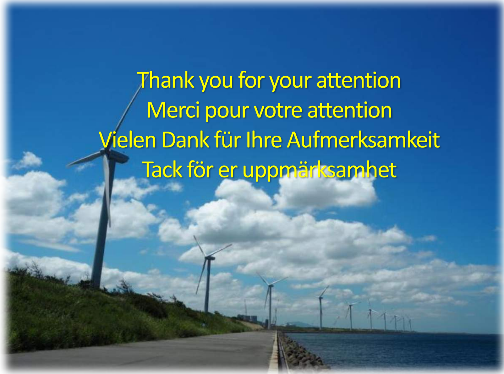
Photo: 響灘風力発電所（福岡県北九州市） 2017/8/4
