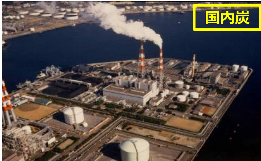
磯子火力発電所（横浜市） 1967年運開
