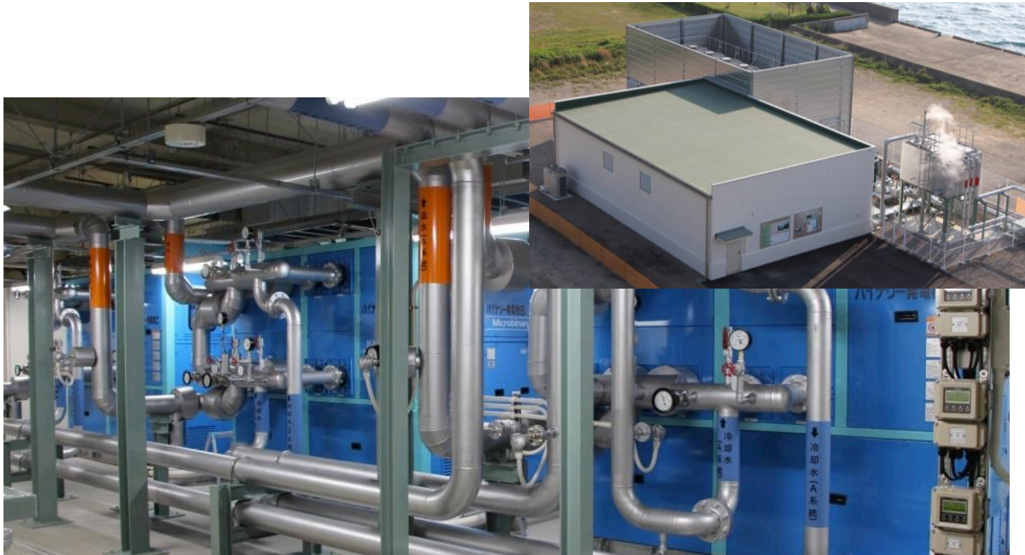
小浜温泉バイナリー発電所 (2013年4月7日～)
