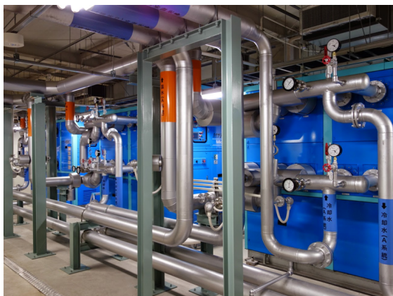
地熱発電 (100kW) 15年
