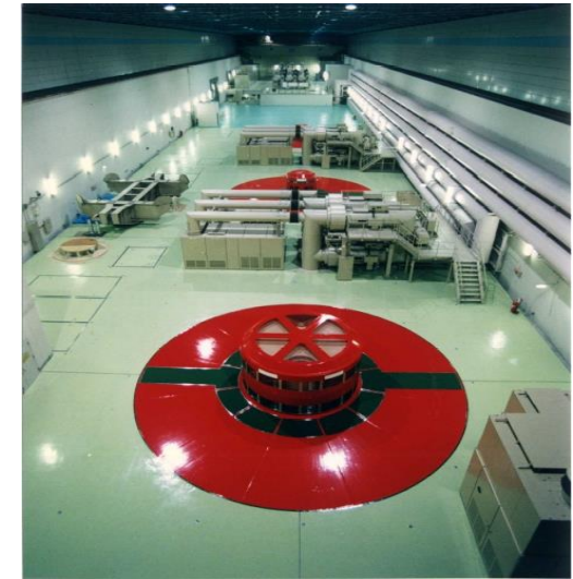
可変速揚水発電設備の外観
