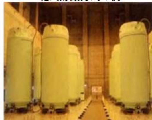
日本原子力発電(株)東海第二発電所での乾式貯蔵 発電所敷地内に貯蔵施設を新設した例
