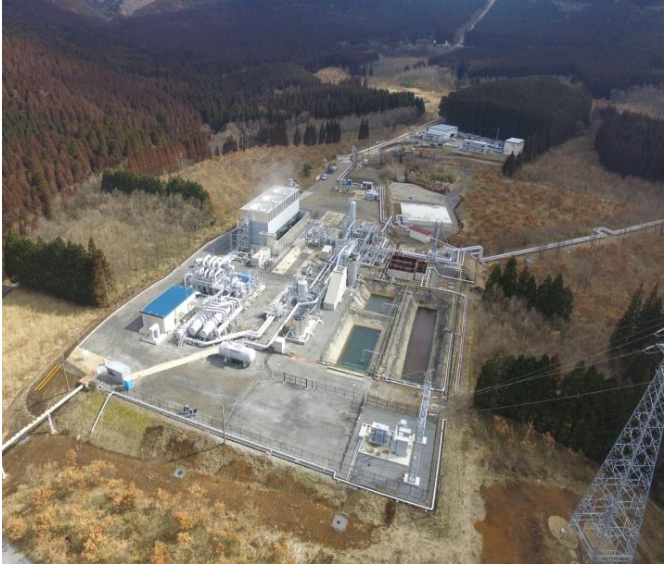
滝上バイナリー発電所
