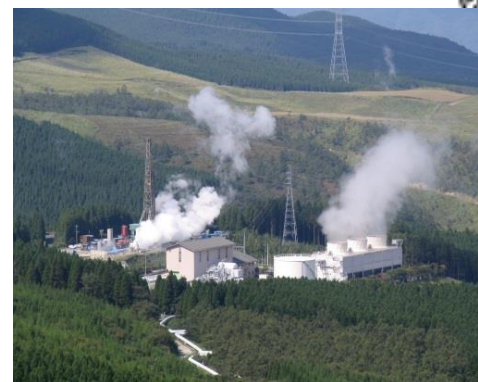
滝上発電所 発電:九州電力 蒸気供給:出光大分地熱
