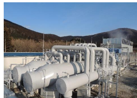
滝上バイナリー発電所
