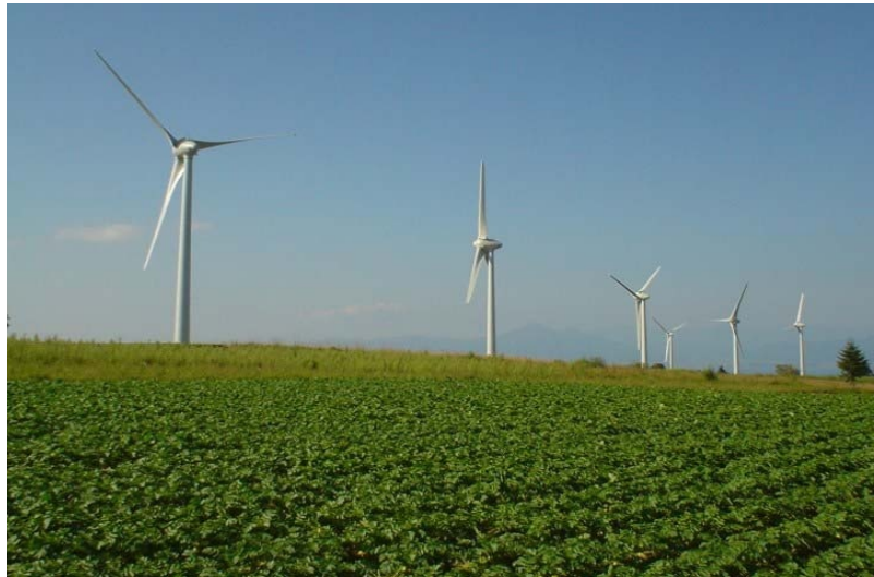
Jパワー・郡山布引高原風力発電所(福島県)
