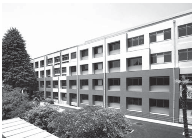
改修工事を行った旧工学部5号館
