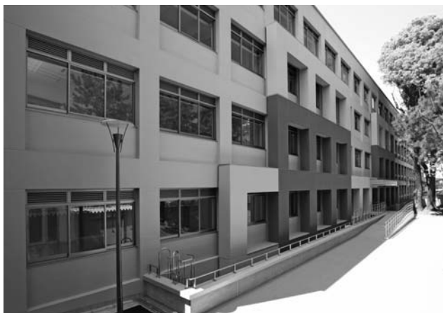
人文科学研究所本館・総合研究4号館の改修
