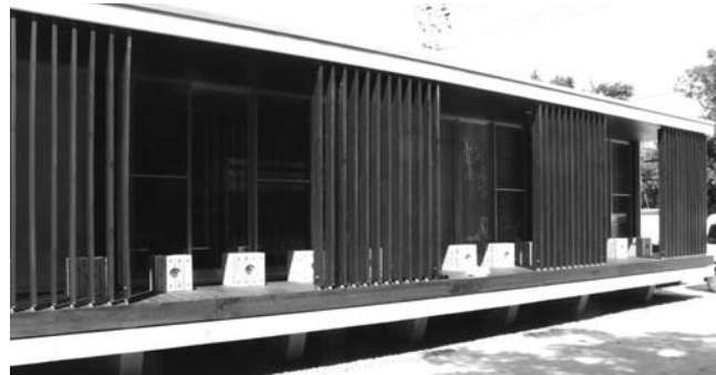
構造材には和歌山研究林の間伐材を利用し、jPod工法によりリニューアルされた「白浜海の家」(jPod工法については、18ページ参照)
