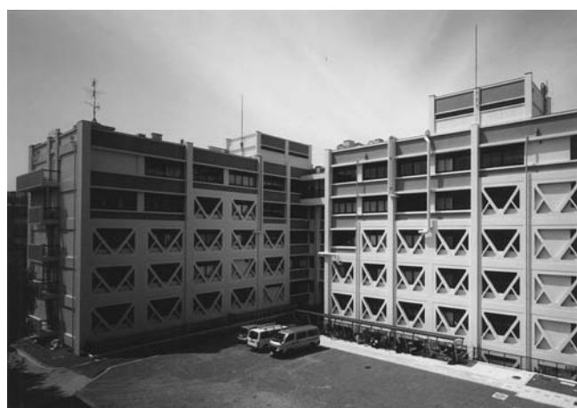
耐震機能改修を行った理学研究科1号館
