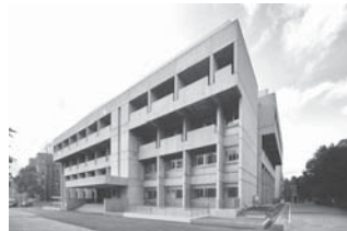
(中央)総合研究棟(旧工学部8号館)外観
