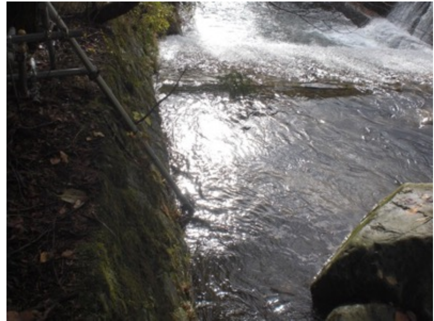
発電所計画地点付近
