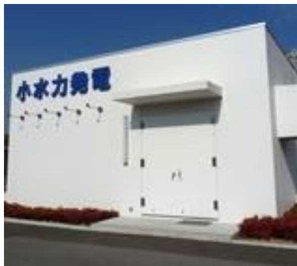
上水道の小水力発電
