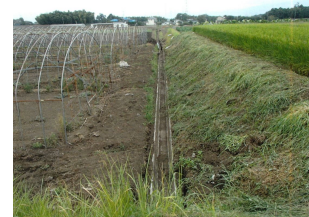
排水管路の整備
