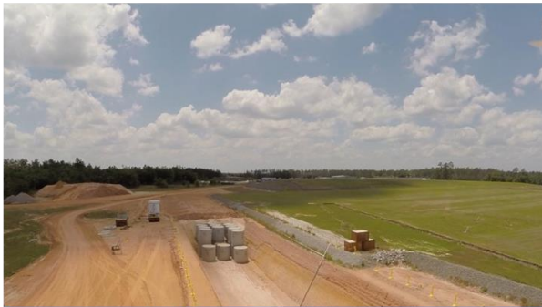
バーンウェル処分溝
