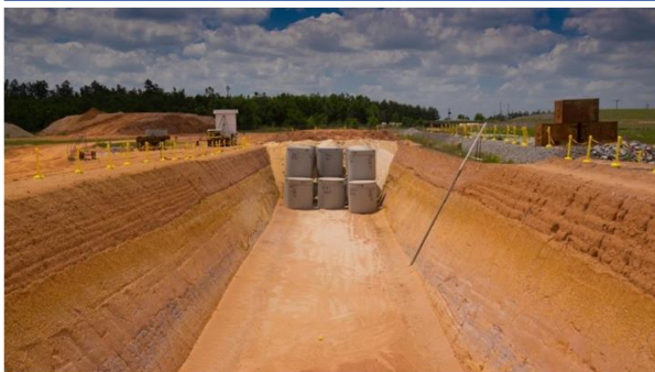
コンテナ廃棄物の処分溝
