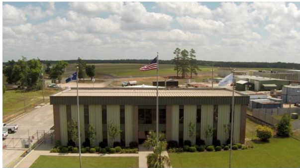
バーンウェル処理および処分施設
