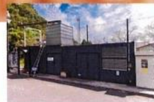
敷地内にある木質バイオオマス発電所。スギの未利用材を加工したチップで発電する。
