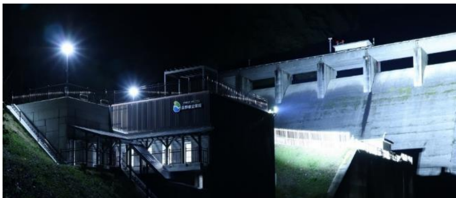
ライトアップ中の発電所
